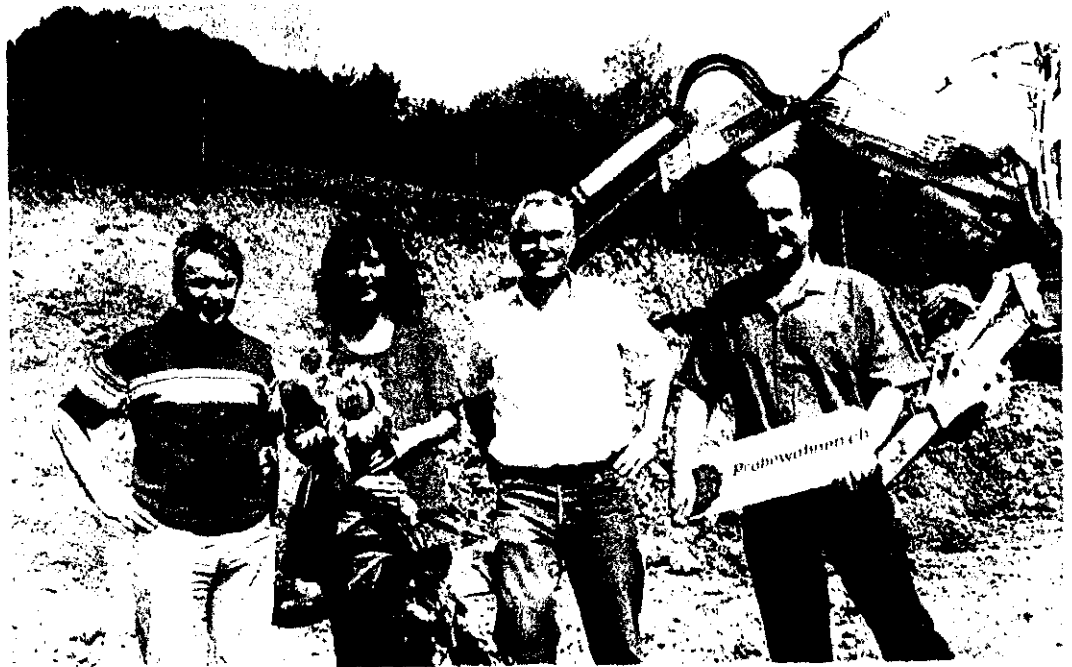
Blumen zum symbolischen Spatenstich: Oswald Huber, Irene Mischler, Roland Faoro und Stefan Mischler (von links) auf der Baustellenzufahrt zum Probewohnen Haus. Im Hintergrund sind dessen Visiere erkennbar. Bild: Hanspeter Thurnherr
